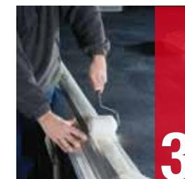
3 Presione con un rodillo suave para ajustar contornos, bordes de unión, remaches o cabezas de tornillos.
